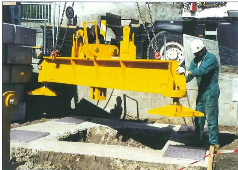
Preparazione del basamento e montaggio della crociera principale
