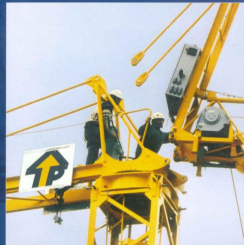
Assemblaggio del braccio e del puntone anteriore
